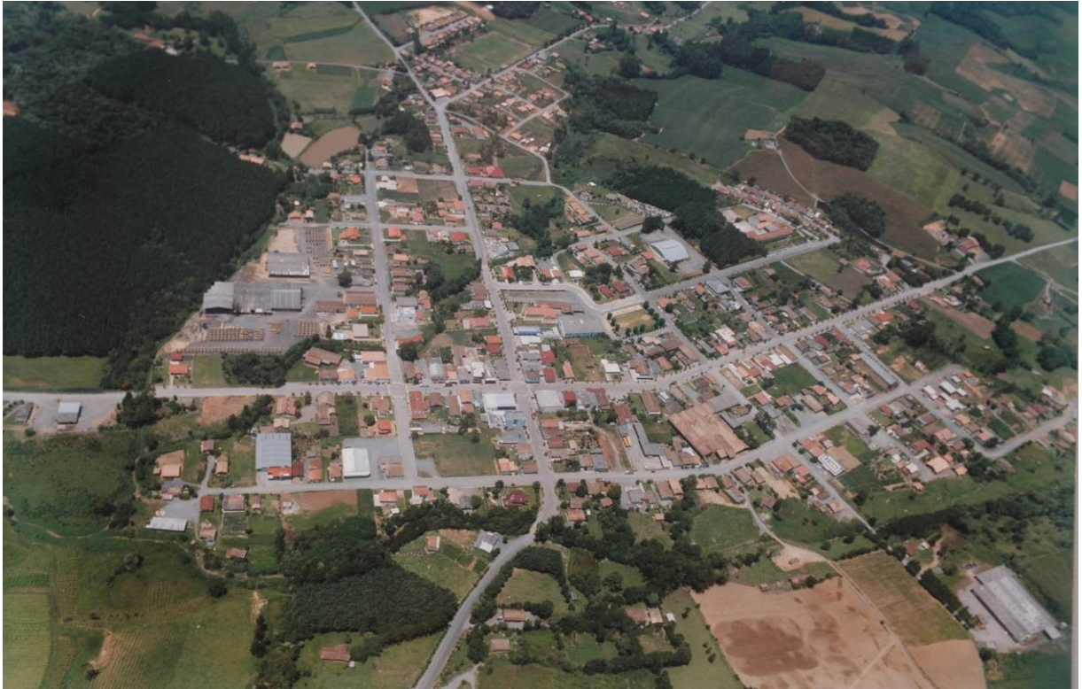
FOTO 01 – Vista Panorâmica - Área Urbana
