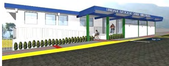
Ampliação Ubs Centro
