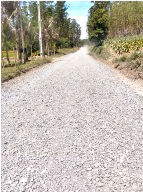
Bica Corrida (Brita) para revestimento primário executado em Atalanta - Projeto Recuperar
